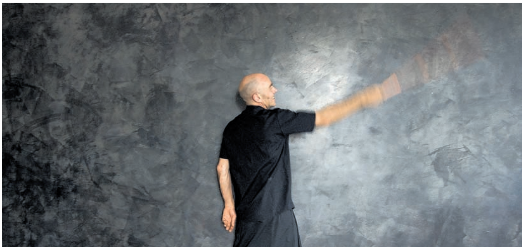
Schwarz in Schwarz. Rolf Fischler verputzt Wände mit Lehm. Lehmputze führen zu einem sehr guten Innenraumklima – und sehen mit ihren Wolken und Kontrasten spektakulär aus. Foto Susanne Lencinas
